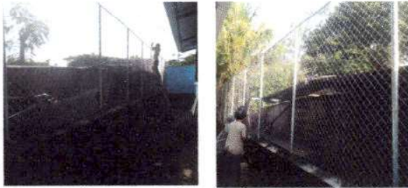
Foto 7: Reparacion de tubo y malla galvanizada en muro perimetral
