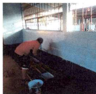
Foto 4: Pintura en muros interiores módulos 1, 2, 3, 4, 5
