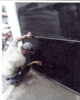
Foto 3: Mantenimiento a portón de metal de entrada principal
