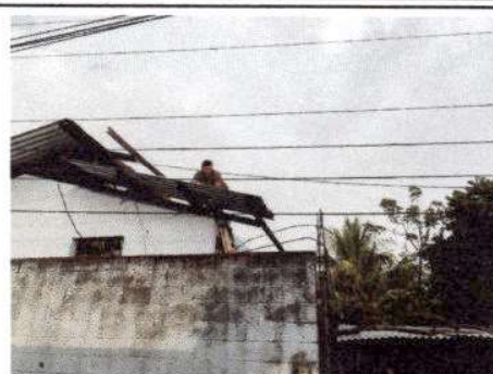
Foto 2: Sustitución de lámina por lámina troquelada aluzinc calibre 26 y mantenimiento a estructura de soporte de metal en módulo 1 y cocina
